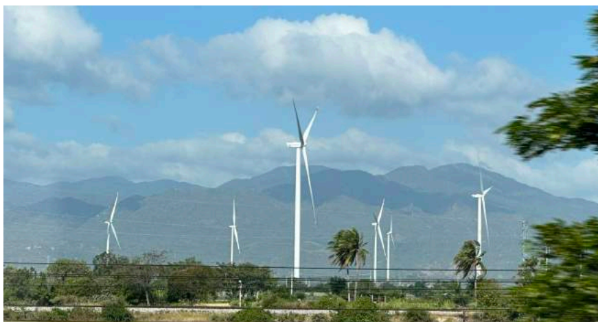
Hình ảnh: Nhà máy Điện gió Lợi Hải 2
