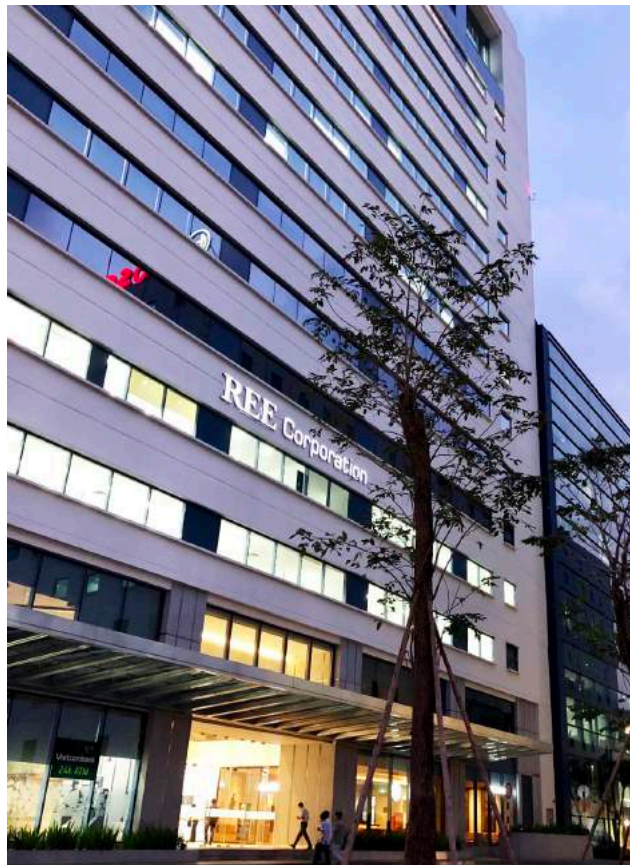
Hình ảnh: tòa nhà e.town 5
