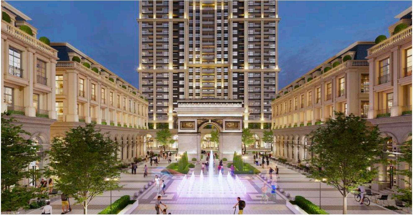
Hình ảnh: Dự án The Light Square – Thái Bình
